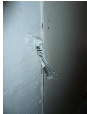
Eksempler på kabelgjennomføringer i branncelleskiller som er tettet og merket på riktig måte.
