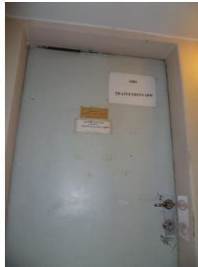
Merking av ståldører inn til kjeller og loft. Merket A 30. Dørene bør byttes.
