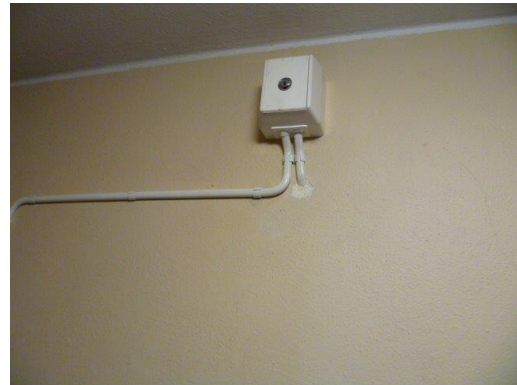
Eksempler på kabelgjennomføringer i branncelleskiller som er tettet og merket på riktig måte.
