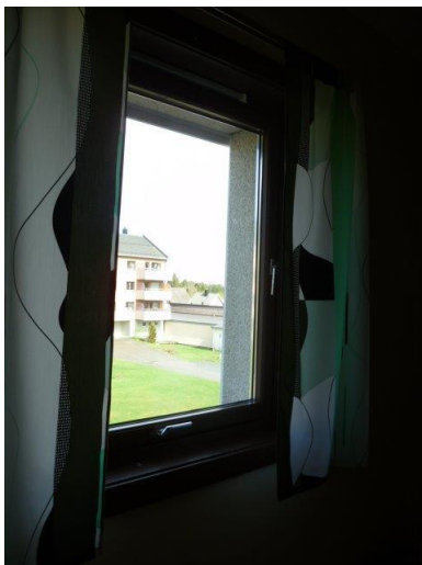
Vinduer i trapperom kan brukes til utlufting av røyk
