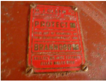
Merking av ståldører inn til kjeller og loft. Merket A 30. Dørene bør byttes.
