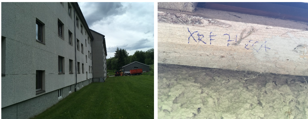
Figur 12: Lektene under fasadekledning med glassfiber er farlig avfall med CCA-impregnering
