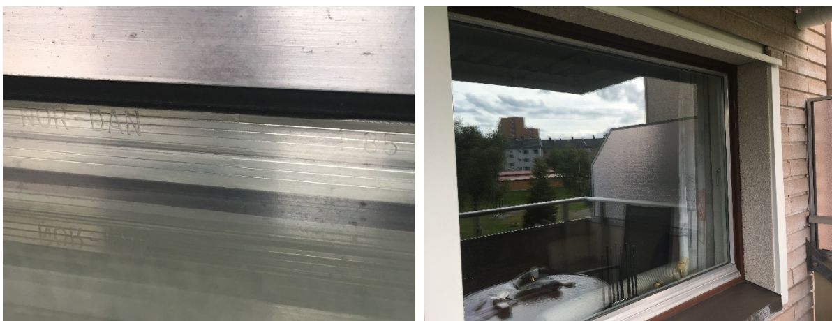
Figur 4: Vindu merket 1985 i avstandsliste. Vinduet håndteres og leveres som farlig avfall med klorparafiner
