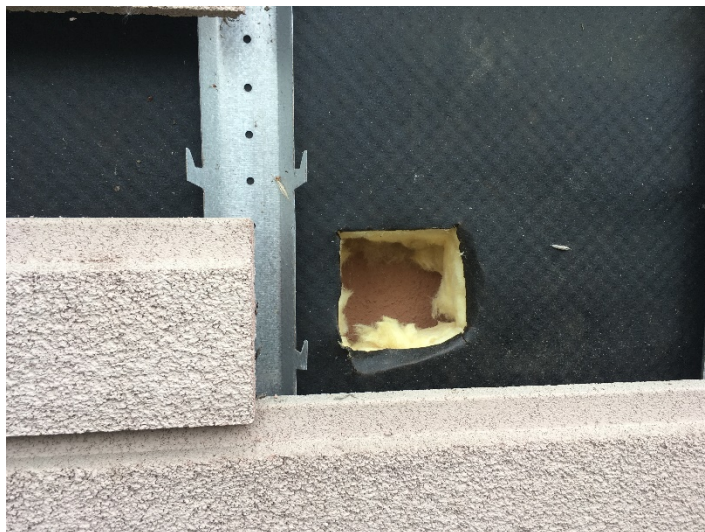
Figur 11: Vindpapp under kledning kan håndteres og leveres som ordinært avfall
