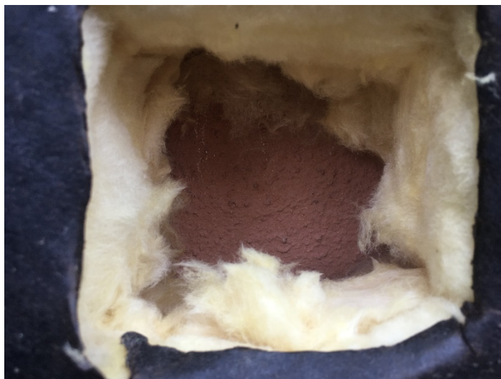
Figur 7: Oppbygning under fasadeplater: Fasadeplater, vindpapp, mineralull
