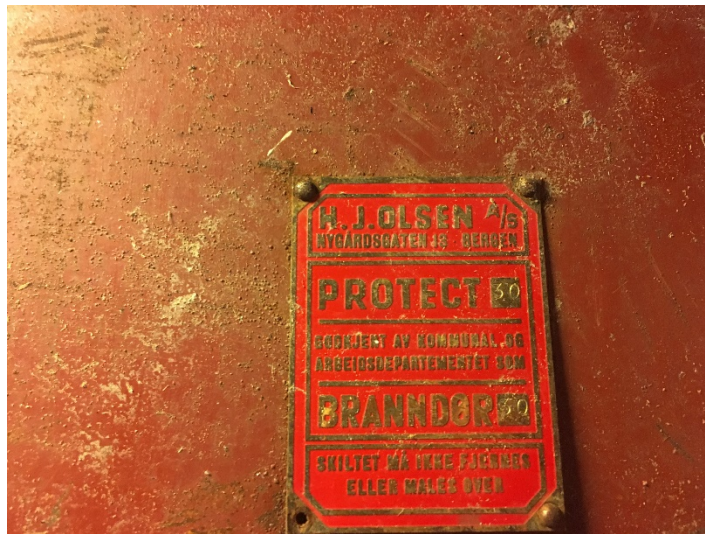
Figur 15: Branndører er merket med slike lapper i metall.
