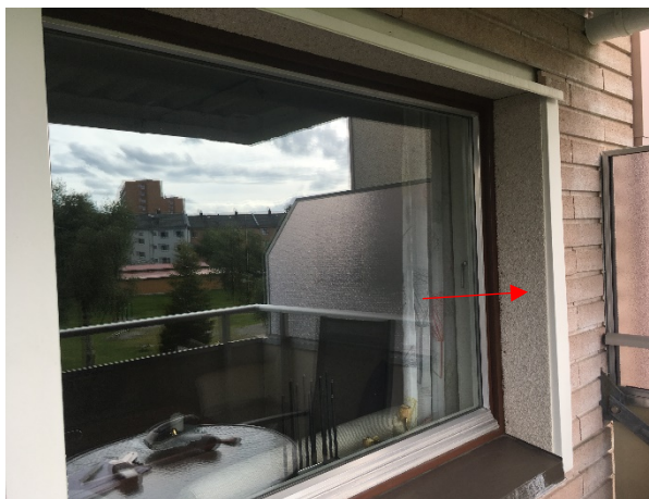
Figur 8: Sinkbeslag rundt vinduer
