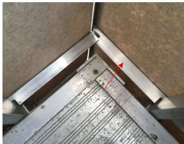
Figur 9: Aluminiumlister på balkong
