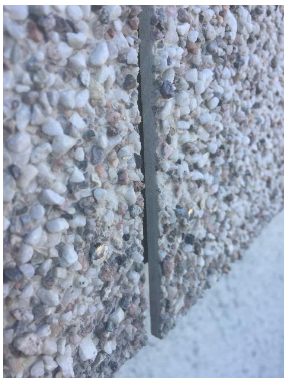
Det ble registrert løs spiker på flere fasadeplater.
